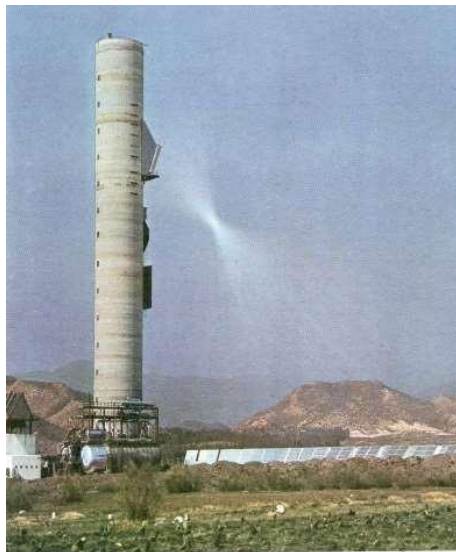
Torre de heliostatos
